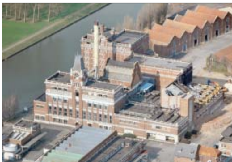
La brasserie-malterie Motte-Cordonnier est visible de l'A25. Symbole d'un passé florissant, le site est en vente.
